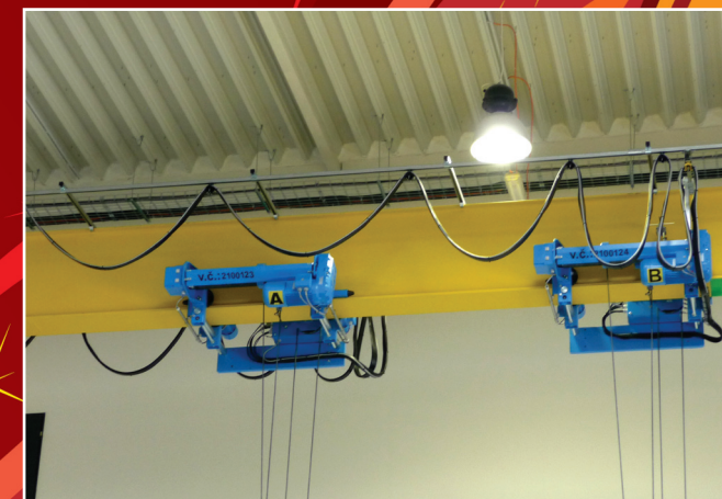
Jednonoskový mostový jeřáb GJMJ 2x3t/22,95m
