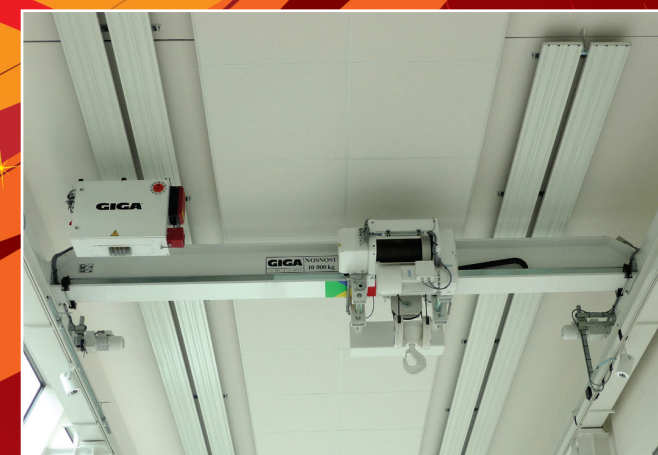
Jednonoskový mostový jeřáb GJMJ 10t/7,28m
